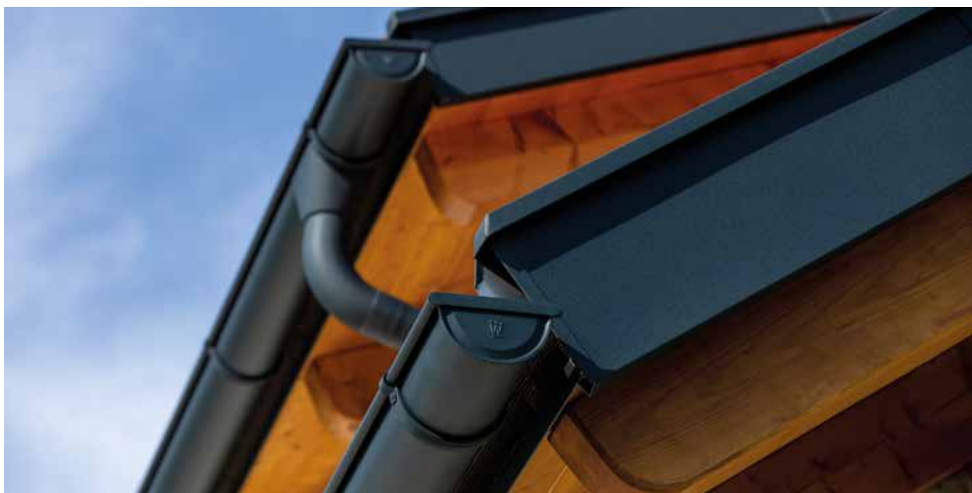
Die moderne Optik und die idente Oberfläche von Rinne, Rohr und Bandblech war für den Bauherren dieses Einfamilienhauses entscheidend. Ausführung: Fa. Klammler, Passail
